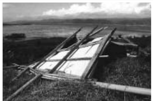
台風により全壊した畜舎
