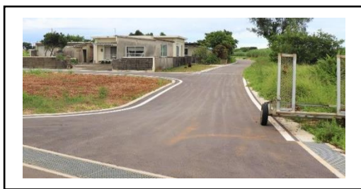
東江上集落道 20号 ほか1件整備工事
