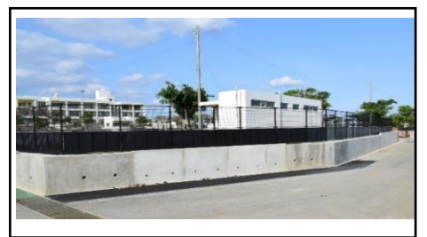
伊江小学校外構改修工事
