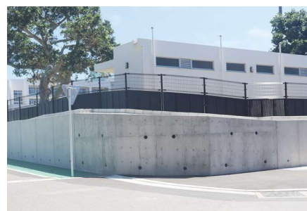
西小学校外構改修工事
