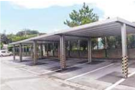
東保育所アーケード設置工事
