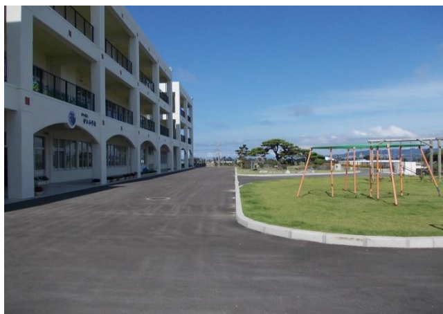
伊江小学校校庭整備工事
