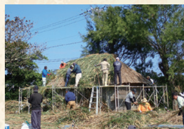
葺き替え作業の様子
