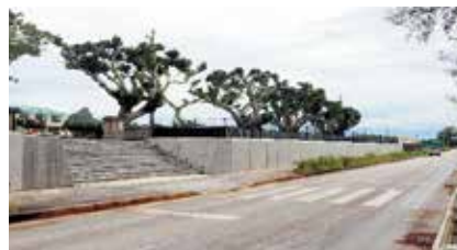
西小学校外構改修工事
