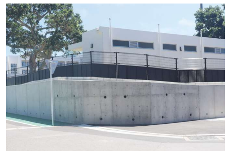
西小学校外構改修工事
