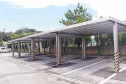
東保育所アーケード設置工事
