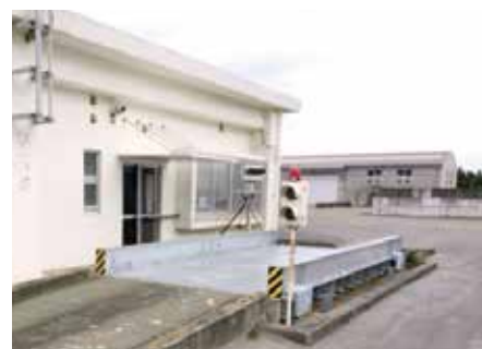
堆肥センター トラックスケール
