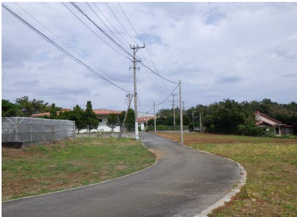
図-9-2 ②老人ホーム西線（現況写真）
