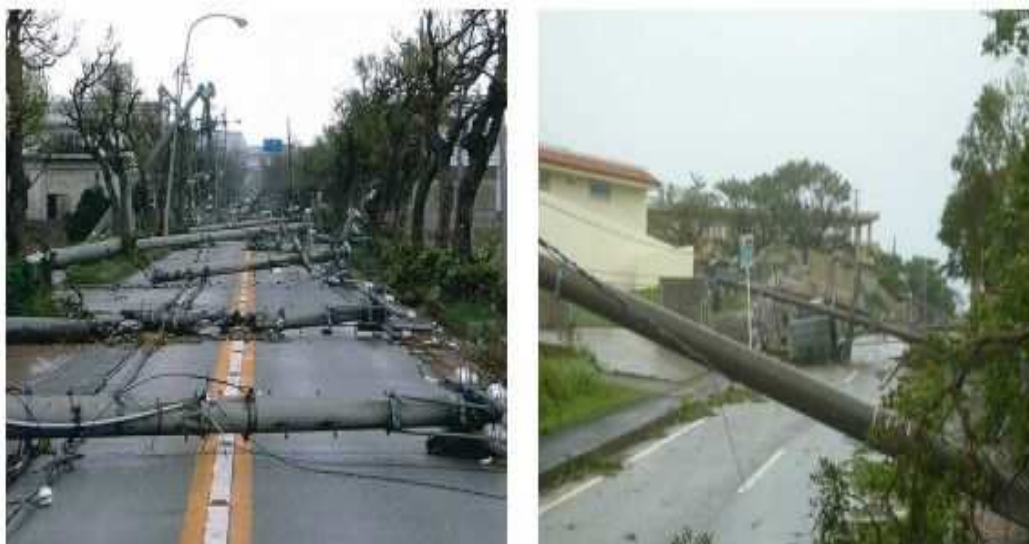
図-2 台風による電柱倒壊状況
