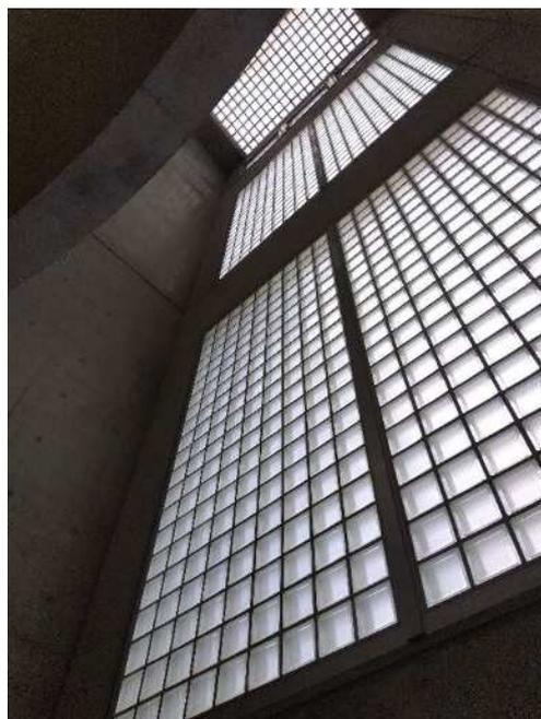
写真-北谷町役場 階段の採光用ガラスブロック
