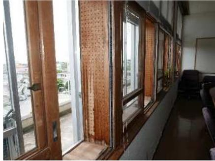
写真-庁舎窓枠木材の劣化
