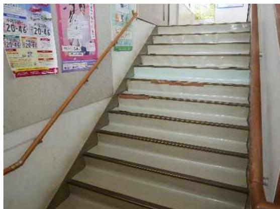
写真-庁舎にはエレベーターが無く床面シートの剥離が見られる
