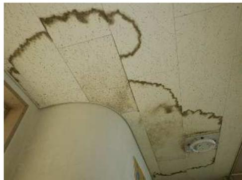
写真-庁舎の雨漏り痕
