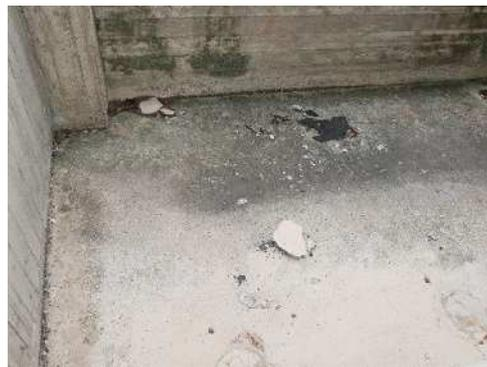
写真-鉄筋爆裂によるコンクリート剥離
