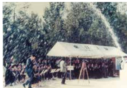
写真 海底送水完成式典の様子
